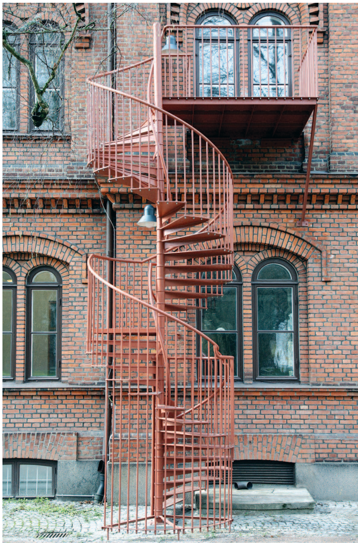
Utomhustrappa med skyddsbur av stålror.
