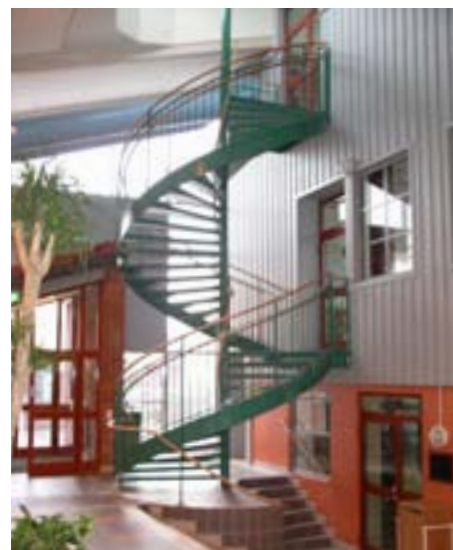
Köpcentrum Spiraltrappa typ Floby. Spiraltrappa med stor radie. Handledare av trä och plåsteg belagda med klinker.
