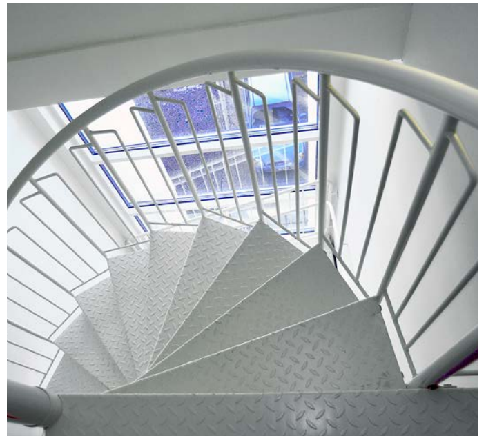
Vitlackerad spiraltrappa monterad i Örebro. Trappsteg av tårplåt. Barnsäkert räcke.
