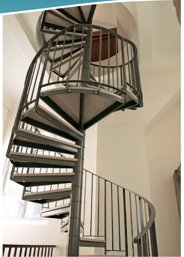
Trapptyp Floby inomhus. Installerad i Lund, Historiska Institutionen. Steg av ask, handledare av plattstål, barnsäkert räcke. "En mycket fin och robust trappa som smälter väl in i den historiska miljön".
