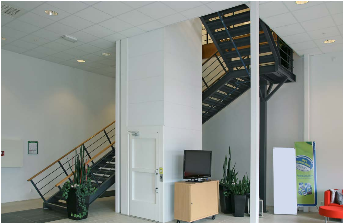
Rak trappa i specialutförande monterad i kontorsdel på logistikcenter. Trappstegen är belagda med klinkers och kontrastmarkeringar på första och sista steget i varje trappplöp. Handledare av ek. Floby Durk har utfört montaget.
