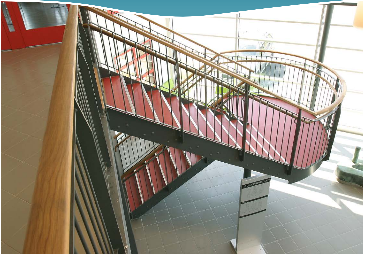
Trulsegårdsskolan Torslanda. Rak specialtrappa med halvcirkelformat vändplan.
